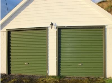
DEMONTERE GAMLE PORTER
