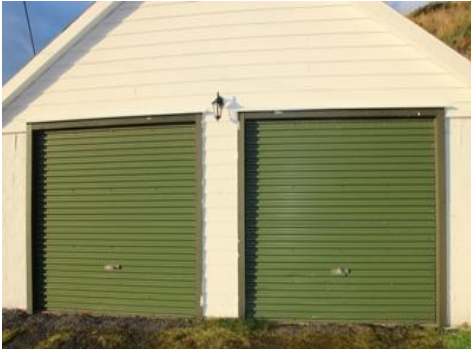
DEMONTERE GAMLE PORTER
