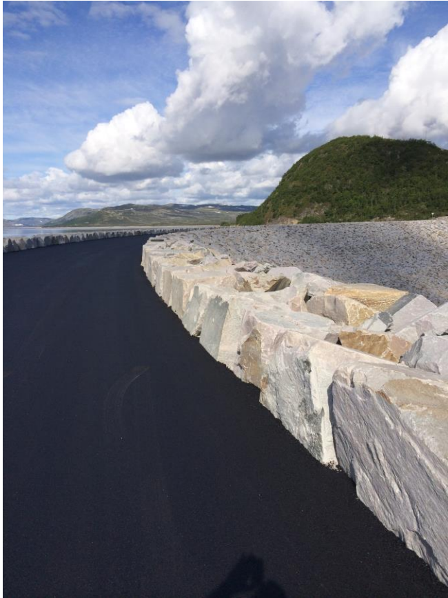
Figur 4. Nedsenket kjørebane på damkrona.
